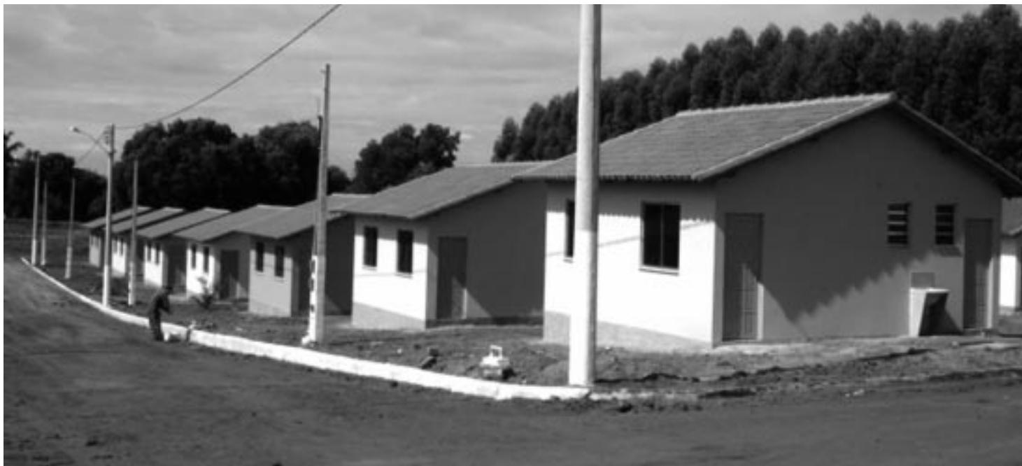
Casas populares estão sendo construídas em São Francisco do Brejão
